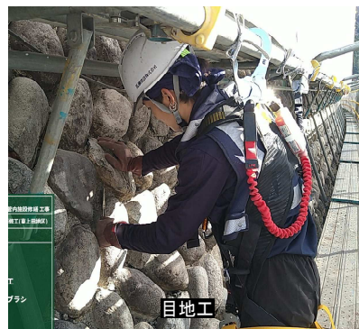
写真-4.1 接着工 作業状況
